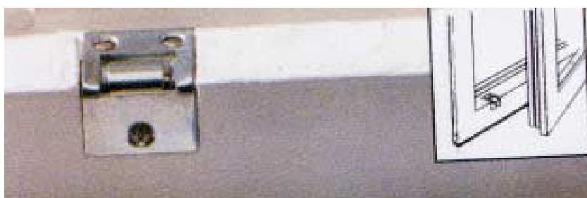
Glidbleck med rulle monterat i karmbottenstycket.
